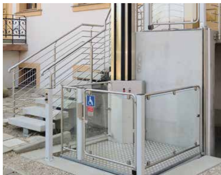
Plattformlift / Hebebühne zur Eingangstür © Frank Duphorn, Duphorn Hebelifttechnik
